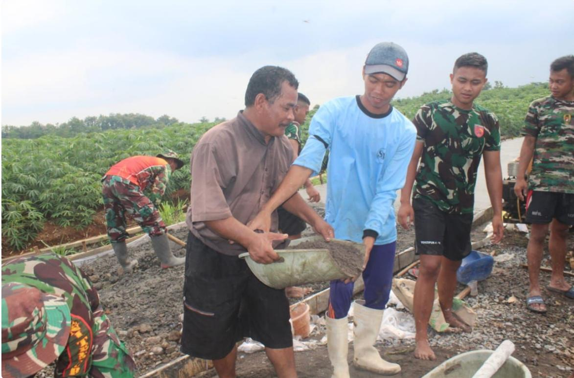
Dengan cara estafet, satu persatu bahan material yang akan digunakan untuk pengecoran dimasukkan dalam mesin molen yang akan di proses menjadi campuran beton.
